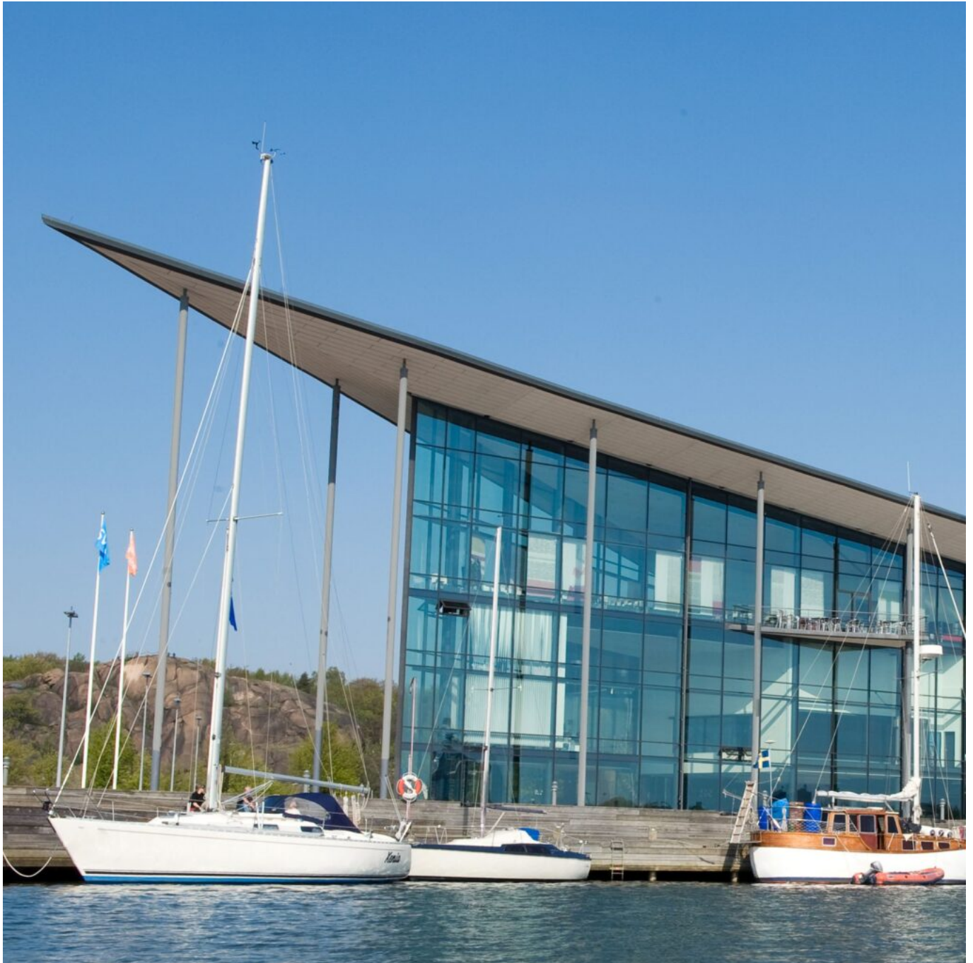
SVT / SR Kanalhuset
